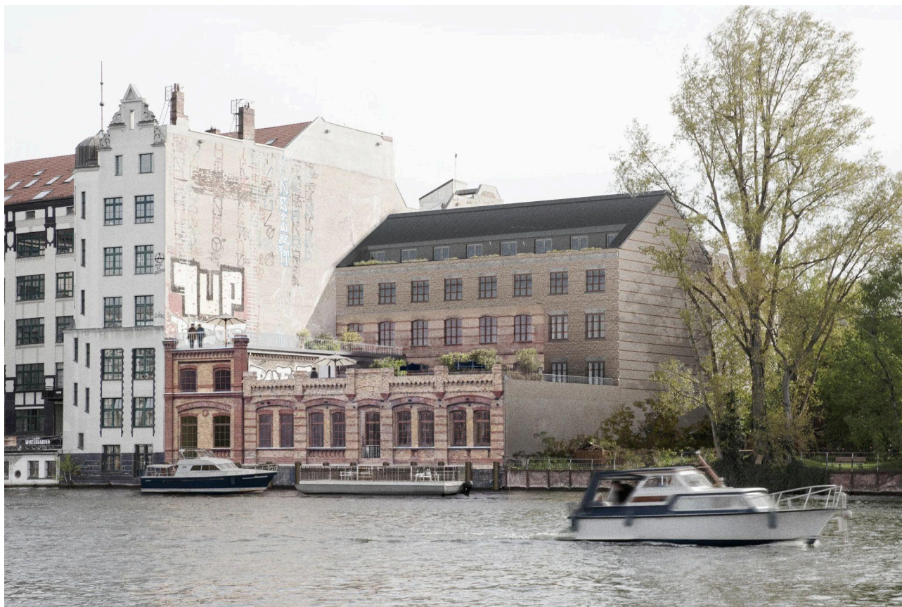
Fabrik Fassade / Spree View
